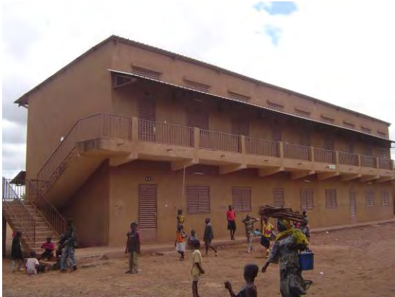
写真-3：バマコ特別区（右岸）Baco Djicoroni 校 フランス政府支援で建設された 2 階建校舎の様 子。現地業者による施工であるが問題はない。
