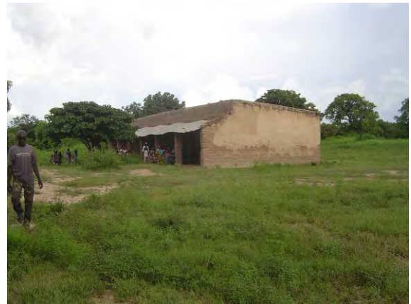
写真-4：クリコロ州（カティ）の Diana 校 住民の自助努力により建設された日干し煉瓦造の 校舎の様子。老朽化が進んでいる。
