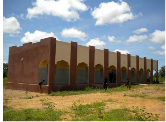
写真-8：クリコロ州（クリコロ）Balla 校 ワールドビジョンの支援により 2009 年に建設され た 3 教室校舎。当該 3 教室のみのため、増設が必要。
