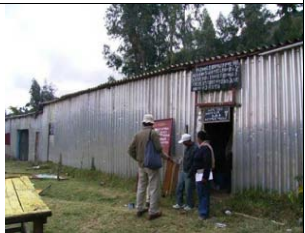
DS-17: デセ市キダメ・ゲビヤ中等学校(仮設学科事務室)
