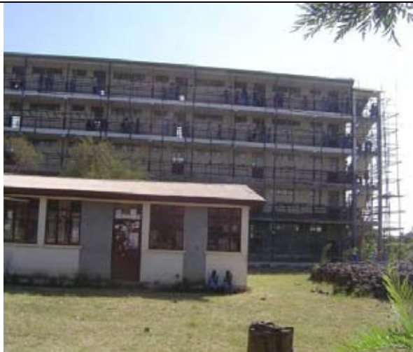
①アムハラ州による5階建て校舎の建設。しかし、教室不足の解消には至っていない。(バハルダール市ファシロ中等学校)
