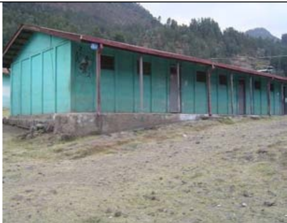
DS-16: デセ市ニグス・ミカエル中等学校(コンクリート壁とトタン屋根の恒久校舎)
