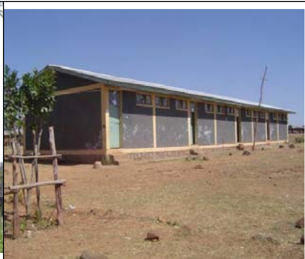
②ドイツの支援により建設された平屋建て校舎外観 (ゴンジ・コレラ町)
