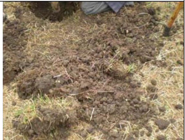
DS-3 : デセ市新設校サイト(膨張土の様子)
