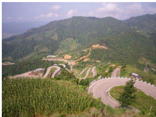
シンズリ郡内のシンズリ道路 カブレ郡のトゥリケルとマホタリ郡のバルディバスを結ぶ総延長 159km の道路。日本の援助で建設中であり、2014 年全線完成予定
