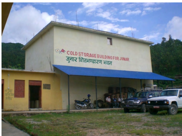
シンズリ郡 日本の援助で建設されたシンズリマディ・ジュナール冷蔵保管庫 収容量約 250 トン
