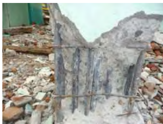
図-89: 柱底部における継手
