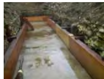
基礎・変形・隙間の無い型枠
