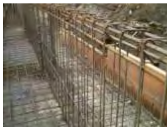
地中梁・美しく組立てられた鉄筋
