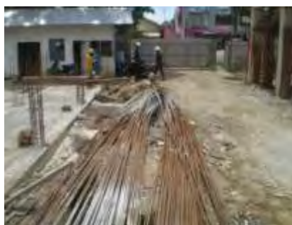
鉄筋の保管状況
