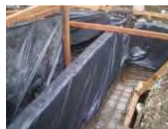
地中梁・コンクリート打設時の 汚れ防止のプラスチックカバー
