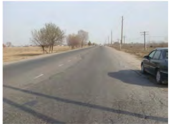
写真-2:既存舗装の状態(54.9km) 片側車線がオーバーレイ補修されている。
