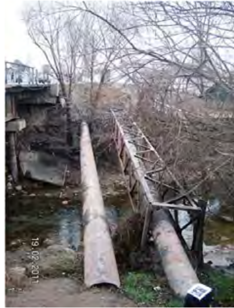
写真-7: 橋梁No.2 ユーティリティ 上流側 ガス管、下水道管、水道管 下流側：水道管
