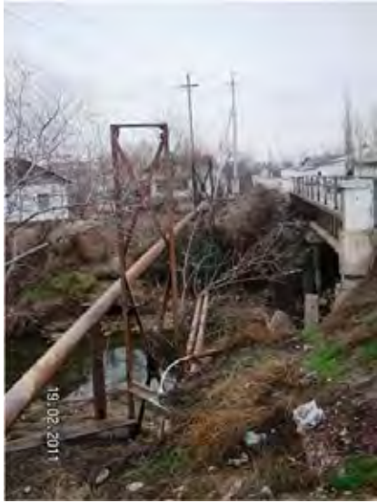
写真-7: 橋梁No.2 ユーティリティ 上流側 ガス管、下水道管、水道管 下流側：水道管
