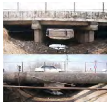
写真-10: 橋梁No.5 下流側全景 同上 上流側全景
