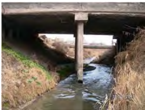
写真-9: 橋梁No.4 上流側全景
