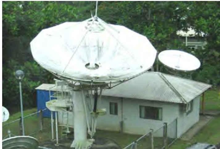
4. スパ本校舎衛星設備（中央が C-band アンテナ、右側が Ku-band アンテナ）
