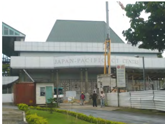
3. 建設中の Japan-Pacific ICT センター（多目的講堂）
