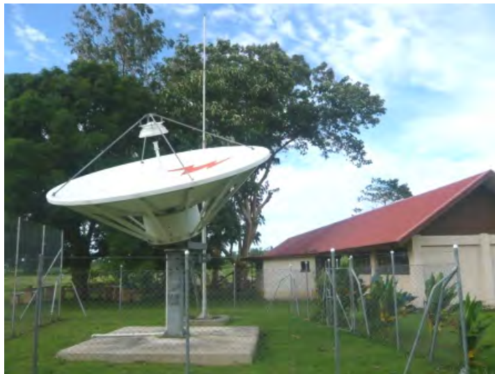
5. トンガ（ヌクアロファ）キャンパスの C-band アンテナ
