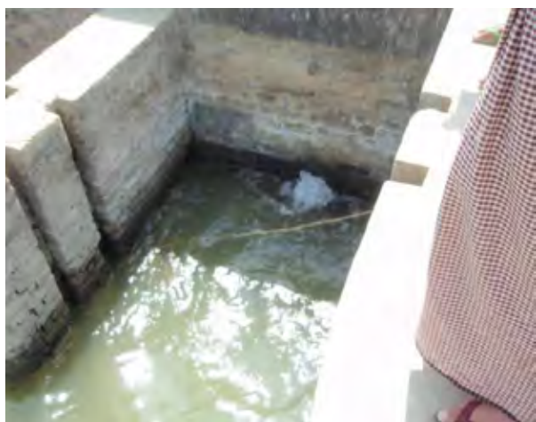
潮が満ちる際の輪中側水門内部（河川側から塩分を含んだ水が入り込んでいる様子）
