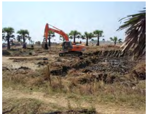
輪中堤防用土取場 (掘削跡地は灌漑局管轄 の飲料用のため池に流用される予定)
