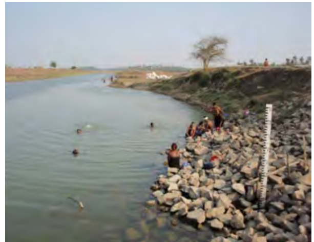
Labuttaloke 改修予定地河川側水路内 (通常河川側の方が浸蝕が激しい)
