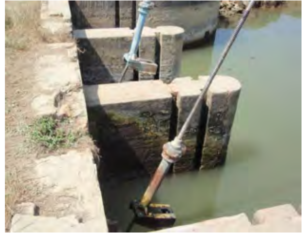
水門河川側フラップゲート (現場で確認のためロープで吊り上げた状態)
