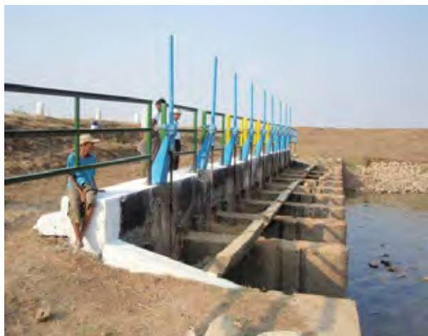
Labuttaloke 輪中側スライドゲート（全部で9門あり、淡水を水路内に貯留）
