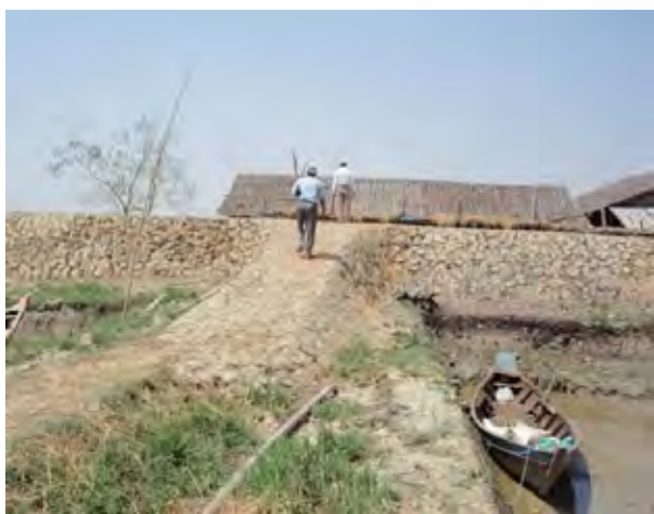
住民の手による防波堤（各農家が労務費負担をして人力による盛土を実施）
