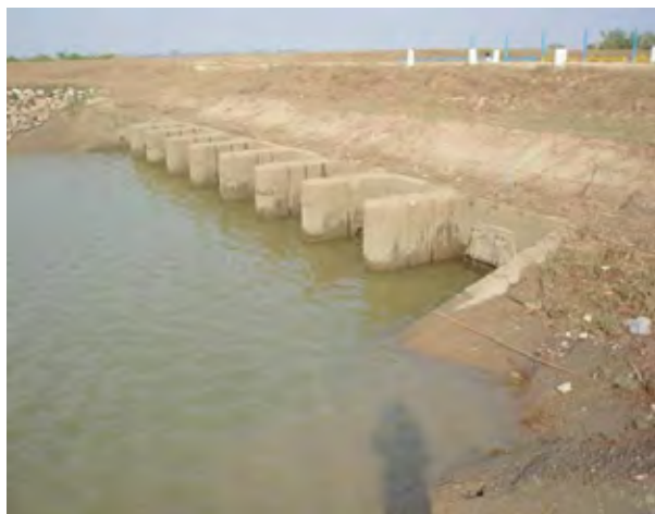
Labuttaloke 河川側フラップゲート（スライドゲートとはヒューム管にて接続）
