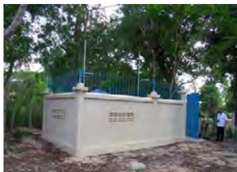
写真 14 : Kravan 観測井戸 (2009 年 10 月完成)
