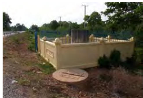
写真 7: SRWSA 生産井戸 (PW-4)
