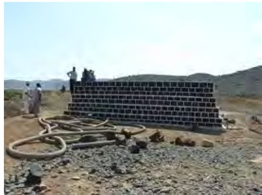
Kourtimalei 貯水槽 ディーゼルポンプで貯水槽に揚水し、貯水槽からホースで圃場へ配水。
