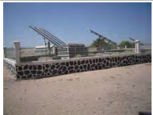
Hanle 1 揚水ポンプ用のソーラーシステム 深井戸が2本あり、1本は飲料、1本は農業に使 われている。
