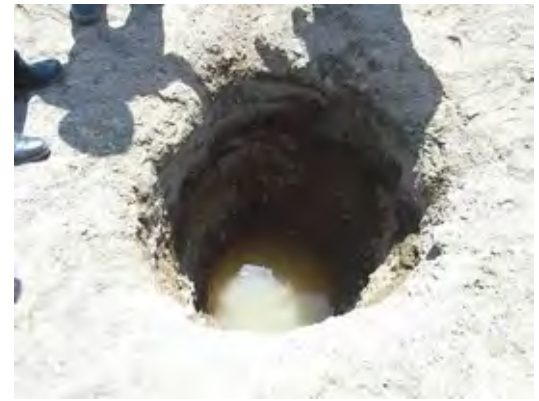
Sek Sabir ワジの中に掘った伝統的な浅井戸 50cm くらい掘ると水があるが濁っている。
