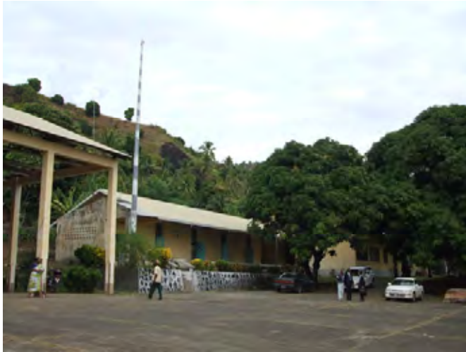
国立水産学校 修理工場と本館
