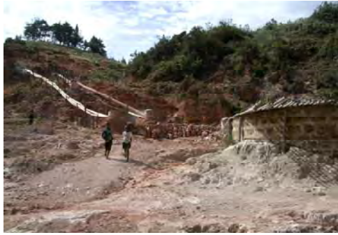
写真-2.2-2 ケニア・エブル地区における地熱有効利用 (左：自然噴気地熱蒸気からの飲料水製造設備 右：地熱水利用の農作物乾燥小屋)
