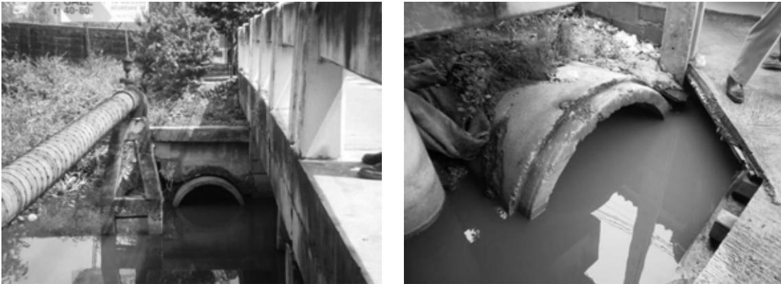
写真 3.7.1 Nong Bon 処理区内既設吐き口の水没状況
