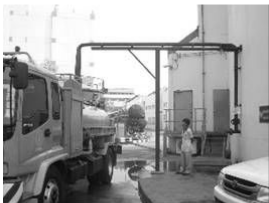
写真 4.2.9 下水処理水再利用（タンク車）
