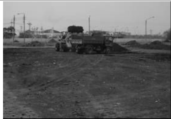
写真 4.2.12 下水汚泥コンポスト化施設
