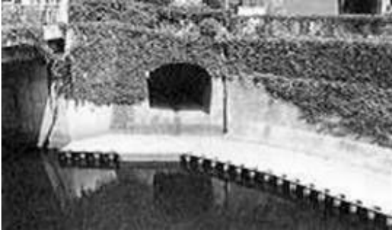
写真 4.2.1、4.2.2 日本の合流式下水道雨天時越流水事例 晴天時(左) 降雨時(右)
