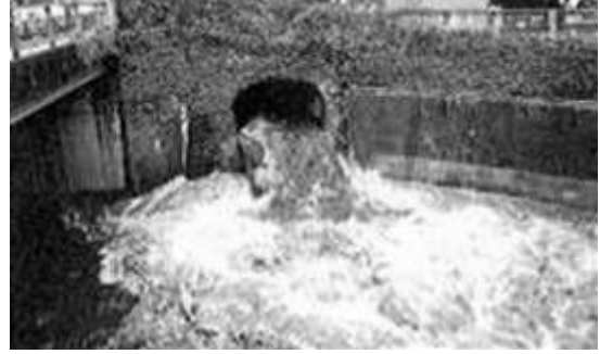
写真 4.2.1、4.2.2 日本の合流式下水道雨天時越流水事例 晴天時(左) 降雨時(右)
