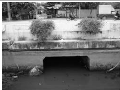
写真 4.2.6 晴天時吐き口状況 4 (2010/06/29)(Chong Nonsi 処理区)
