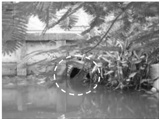
写真 4.2.3 晴天時吐き口状況 1 (2010/06/29)(Rattanakosin 処理区)
