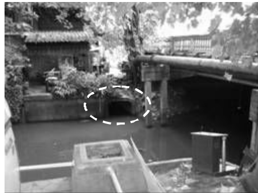
写真 4.2.4 晴天時吐き口状況 2 (2010/06/29)(Rattanakosin 処理区)
