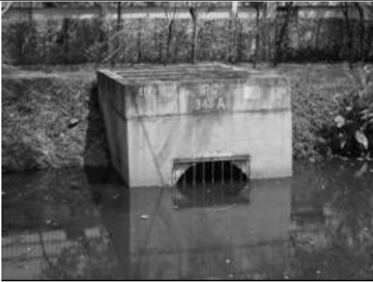
写真 3.6.3 分水人孔の水没
