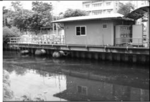
写真 4.2.8 既存の雨水ポンプ場 ( Nara Thiwat Rajanagarindra 通り沿い )
