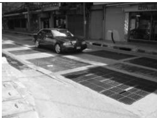
写真 3.4.5 No.1 Sukmvid Soi 26 トンネル 起点マンホールポンプ場
