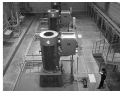
写真 3.4.8 No.7 Makkasan トンネル 流末ポンプ室
