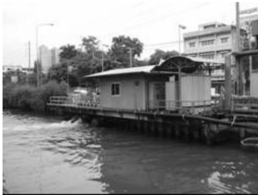
写真 3.4.3 既存雨水ポンプ場 (Nara Thiwat Rajanagarindra 通り沿い)
