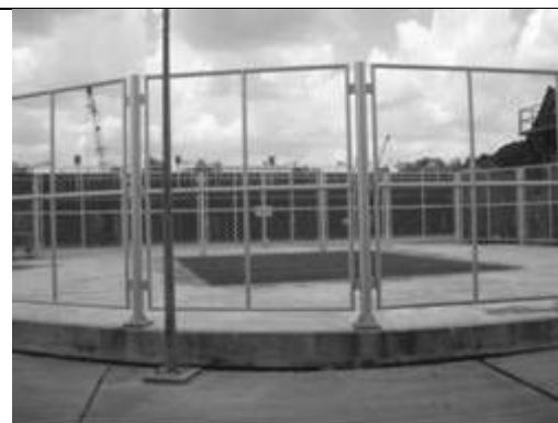
写真 3.4.6 No.6 Klong Saen Saep トンネル 起点マンホール
