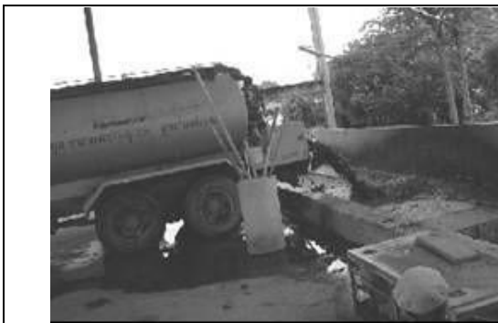
写真 3.4.11 腐敗槽汚泥搬入・スクリーニング
