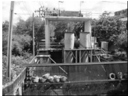
写真 3.4.4 既存雨水ポンプ場 (Phetchaburi 通り沿い)
