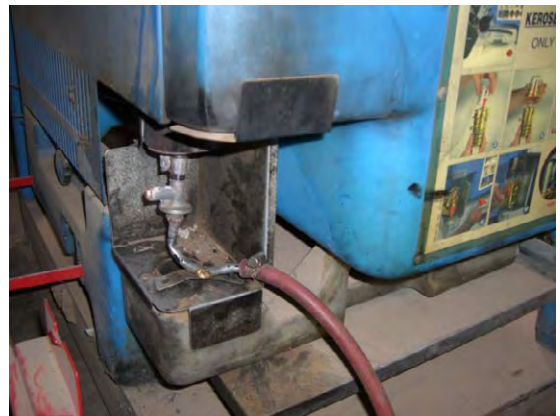
写真-6 保健センターの冷蔵庫 住民保健協会により、灯油式冷蔵庫を燃料費の安いガス式に改造した。
