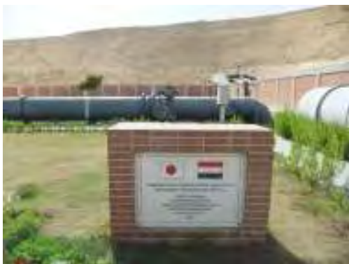
エルラメイヤ配水場入口付近に設置された 記念碑
