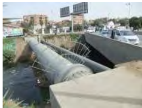
マンソリア水管橋
