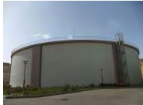
エルラメイヤ配水池外観
