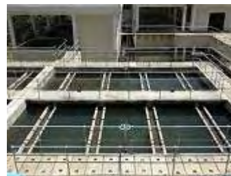
マリimbaダ浄水場沈殿池
