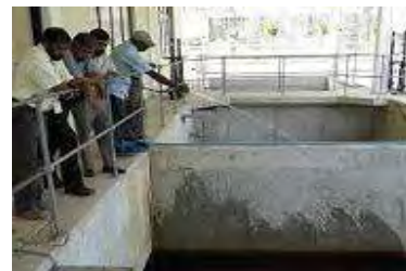
マリンバダ浄水場ろ過池
