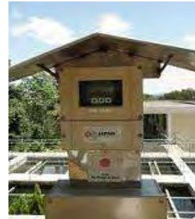
浄水場電磁式流入流量計
