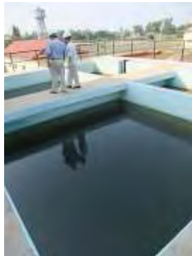
着水井上流部
