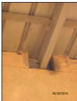
写真3 屋根の梁と外壁の間に隙間ができています
