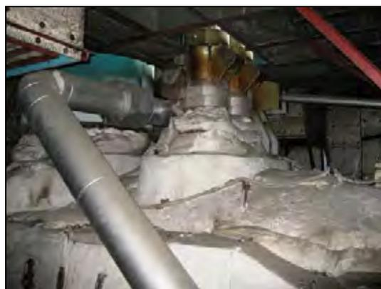
写真2：3号機蒸気タービン内部（蒸気弁）
