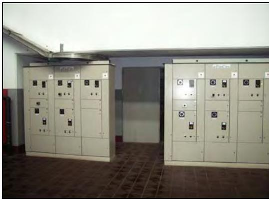
写真 1：動力制御盤
