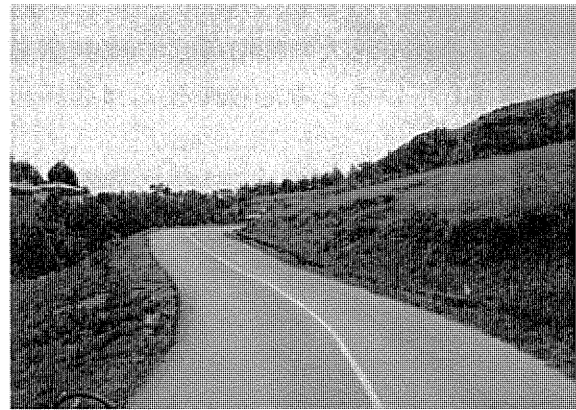
補修されたディリーカーサ道路
