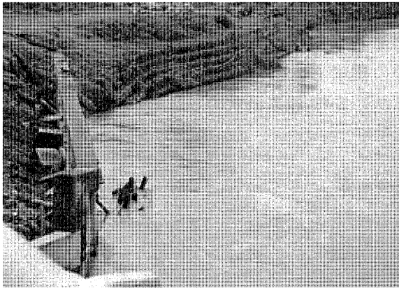
ココブカ I 橋付近の浸食防止工(ブオル県)
