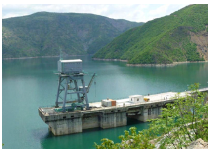
図 6 取水口 (フィエルツァ発電所・貯水ダム)
