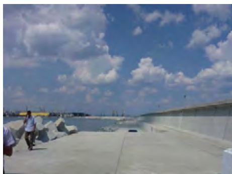
図6 本事業で建設された防波堤
