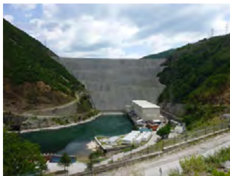
フィエルツア発電所（建屋・ダム）
