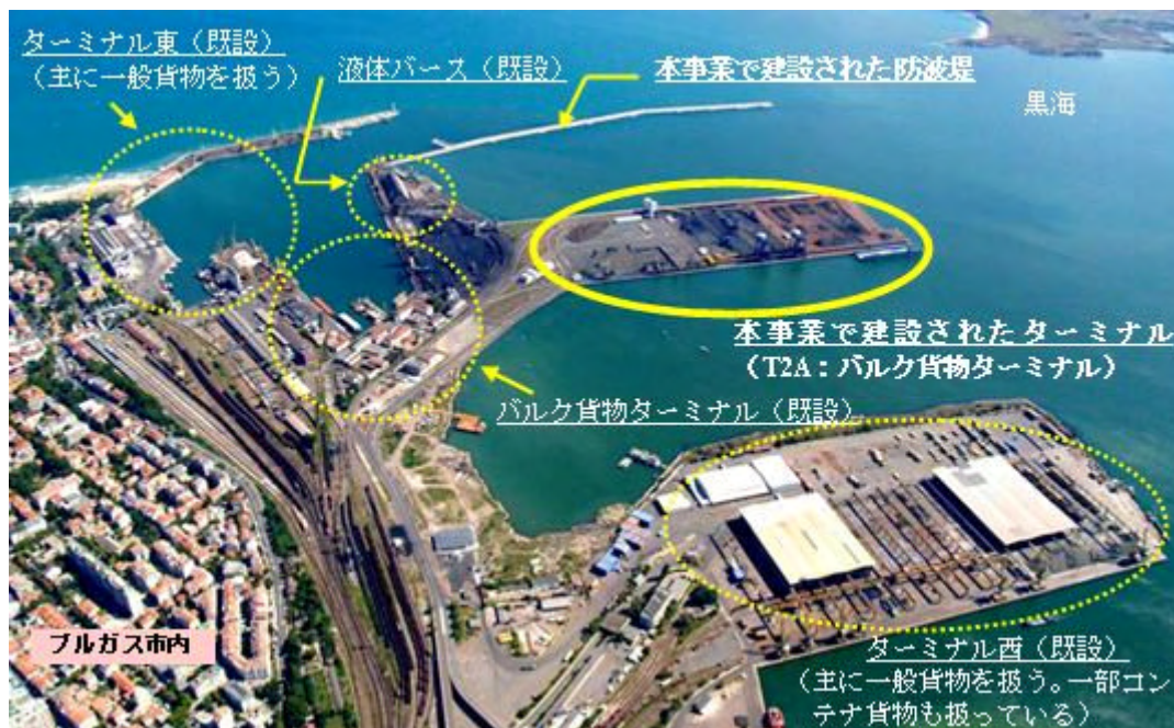
図 1 プロジェクトサイトの位置 (1) (ブルガス港全景)
