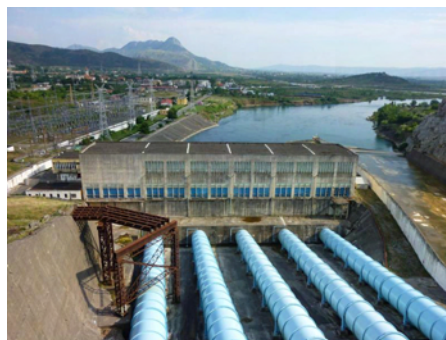
図5 水圧管路(下)・発電所建屋(中央)、 変電施設(左上)(バウイデジャス発電所)
