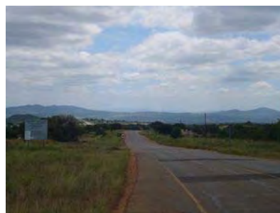
幹線道路 5 号線ムリバ周辺 対象事業始点
