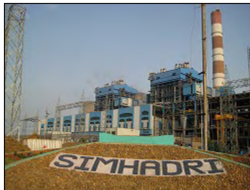
シマドリ火力発電所
