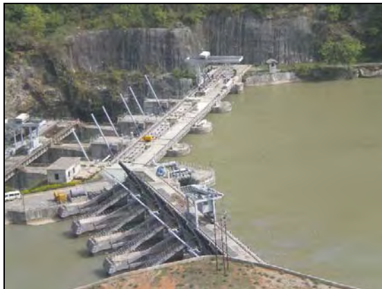
完成した取水ダム
