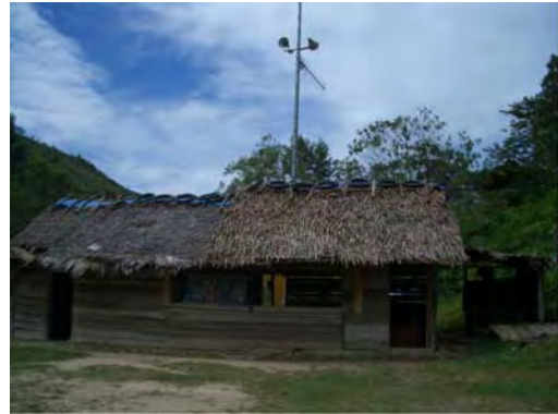
警報装置が入った構造物
