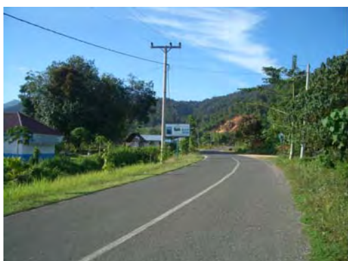
本事業により建設されたアクセス道路
