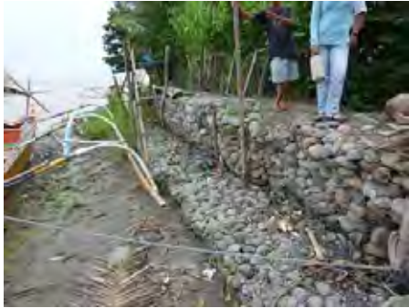
図9 川岸侵食防止のための蛇籠
