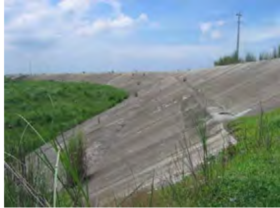
本事業で改修された南西メガダイク
