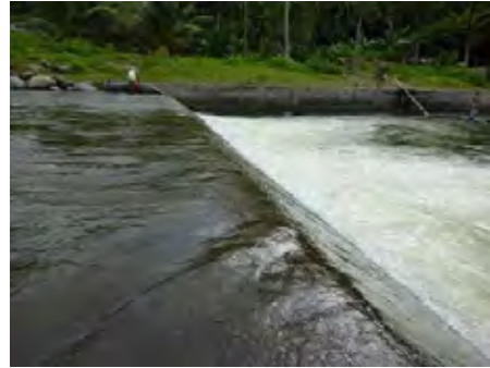
図10 堆砂防止のための練石積工
