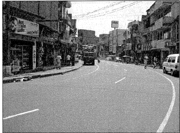
拡張整備された道路（国道 AA005）
