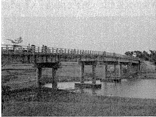
写真 1：本事業にて整備された橋（ジャマルブール県）
