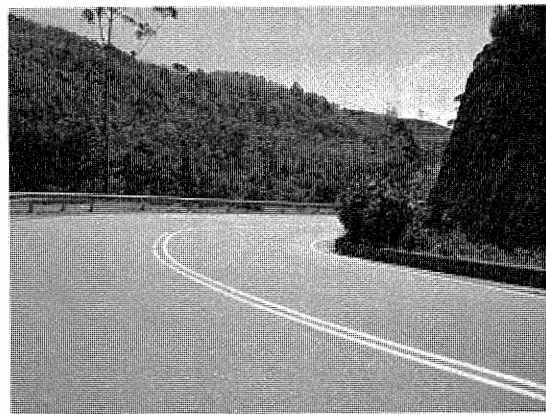
写真 2：改良された道路線形（国道 AA005）
