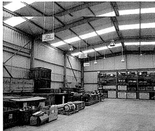
変電所敷地内の予備部品倉庫
