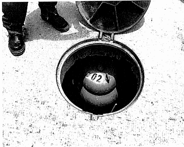
送水管のガス排出口
