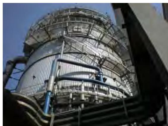
図 12：排煙脱硫装置
