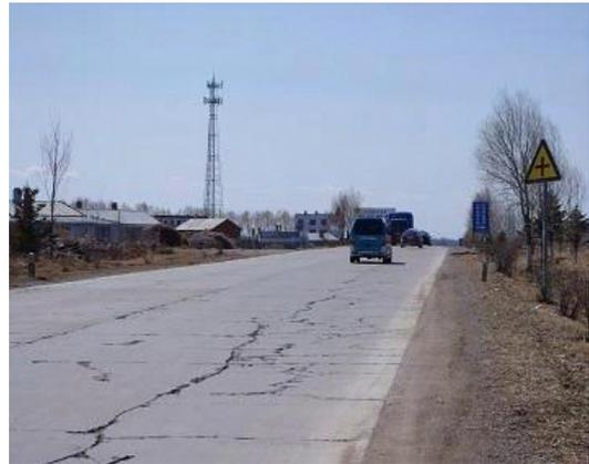
図 14 路面上のひび割れ
