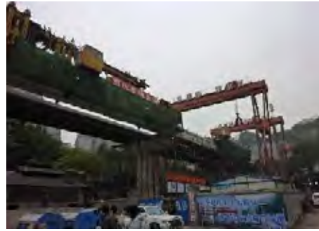
図7 建設中のモノレール3号線
