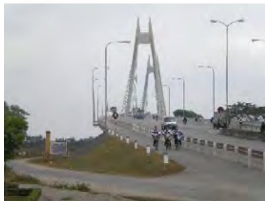
完成したビン橋（南側アプローチ道路より）
