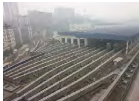
図3 車両基地（大堰村駅に隣接）
