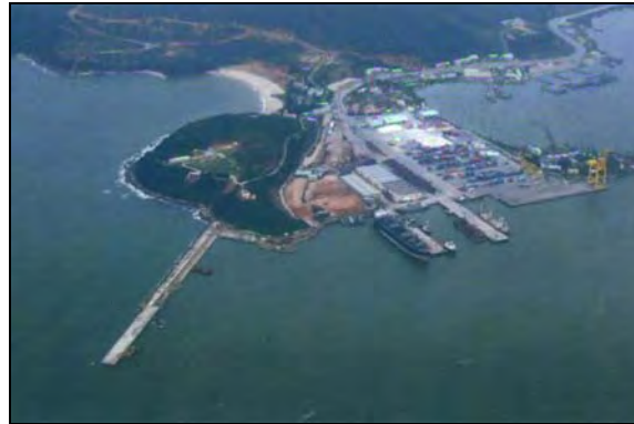
Tien Sa Terminal
