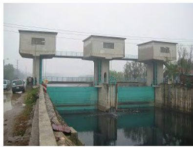
タンリエット洪水調整ゲート
