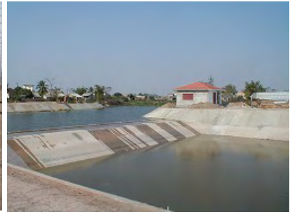
イエンソーポンプ場の余水吐け (Spillway B)
