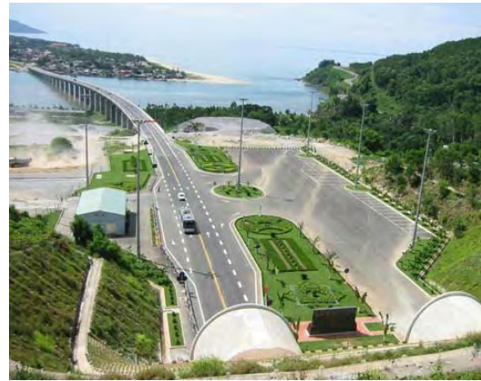
北側トンネル区間とランコー橋 (PMU85 提供写真)
