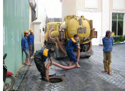
HSDC 職員による下水管の保守
