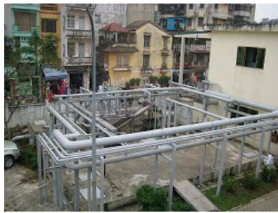
キムリエン下水処理場
