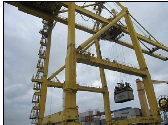
岸壁コンテナクレーンの操作
