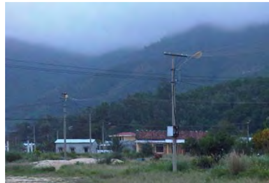
本事業が整備した移転地
