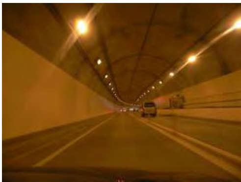
トンネル内部の状態
