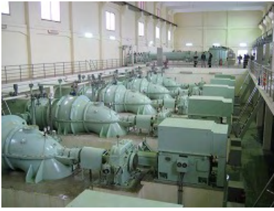
イエンソーポンプ場
