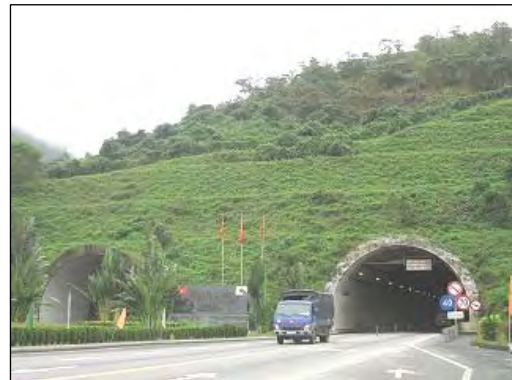
メイントンネル（右）と避難用トンネル
