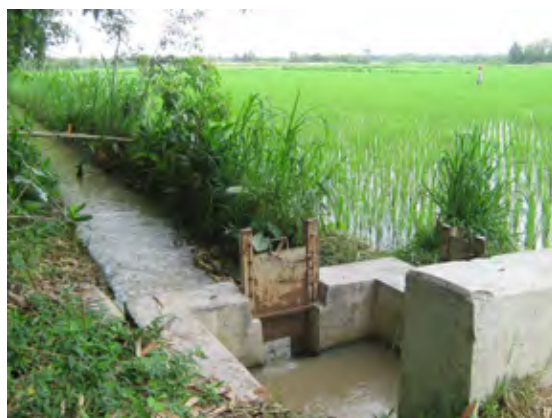
灌漑 3 次水路と水門
