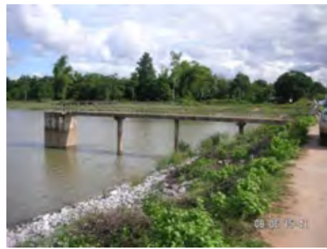
取水施設／貯水池の取水塔
