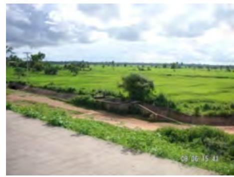
取水塔からの取水管（底樋）出口
