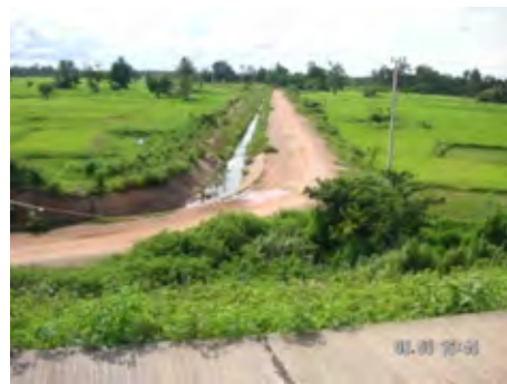
幹線水路／コンクリート水路
