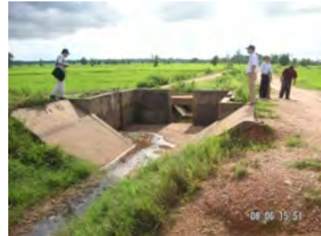
幹線水路途中の分水工
