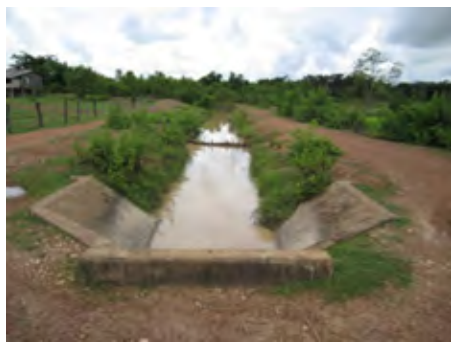
幹線水路／土水路
