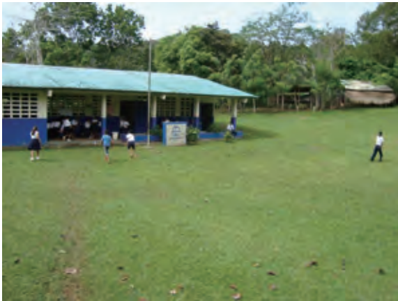
Escuela Quebrada Ancha
