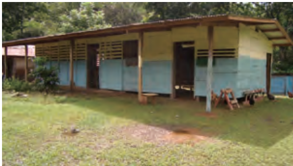
Escuela Quebrada Fea
