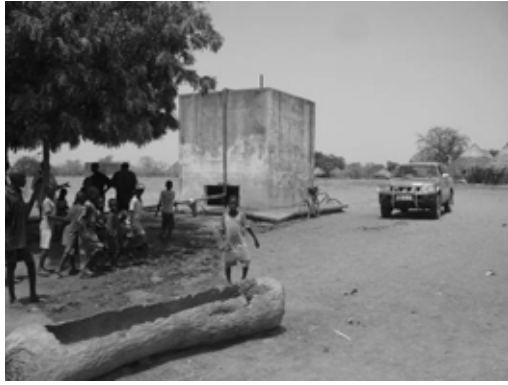
古いコンセプトの地上型水槽施設
