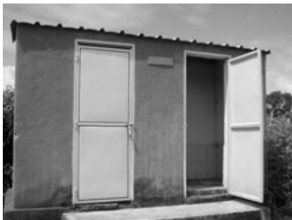
UNICEF 建設の学校トイレ (旧タイプで明かり取りが無く暗い。 ケドゥグ州)
