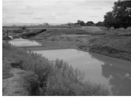
河川流量観測地点の例 (4) Gabou 村近傍
