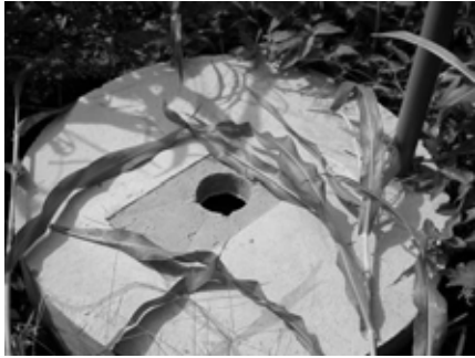
石積工により建設された DLV トイレ (1 槽目蓋あり)
