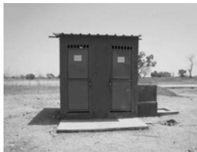
UNICEF 建設の学校トイレ 新しいタイプで明かり取り/手洗 い場付き
