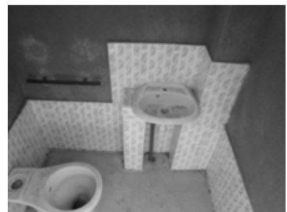
左は健常の生徒用個室。上は障害を 持つ生徒用個室。衛生便器の下には 直下型の便槽が掘削されている。
