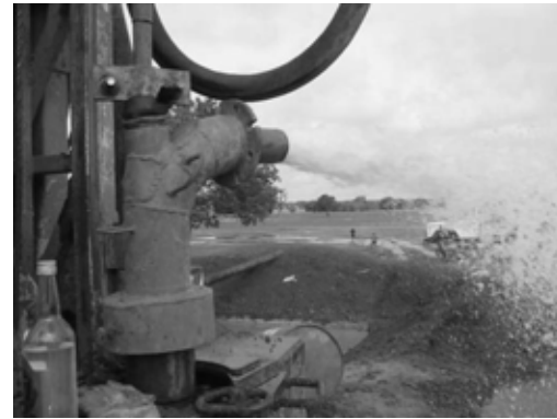
試掘の井戸洗浄
