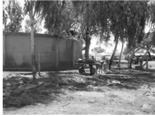
古いコンセプトの地上型水槽施設
