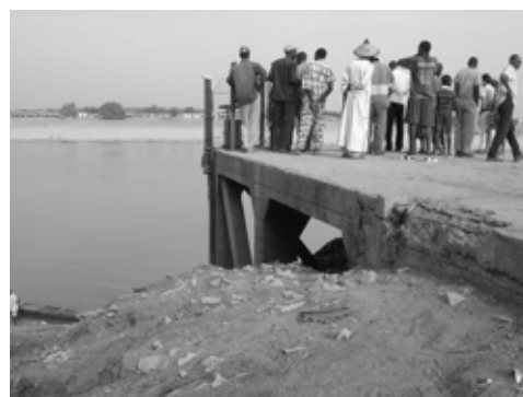
既存河川流量観測所の例 (3) Matam 観測所
