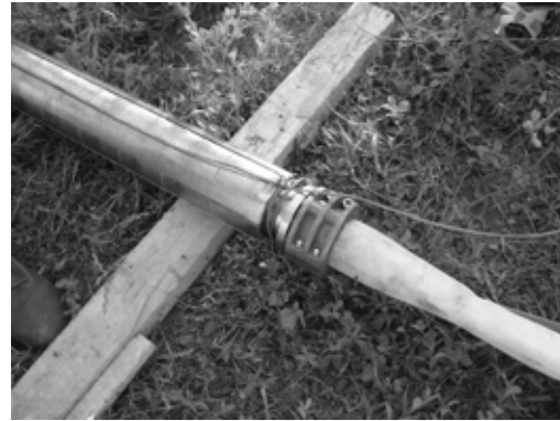
揚水管の腐食対策
