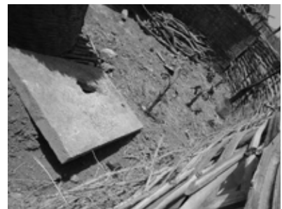
便槽満杯になったため SAN PLAT を外して右に掘削中。
