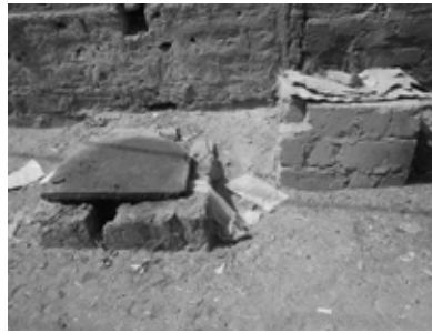
生活排水溝 (マタム州) 現在は利用されていない
