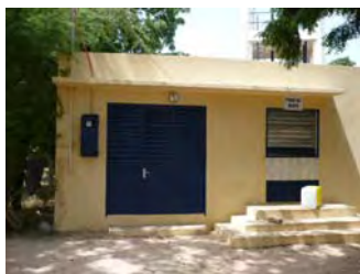
脱塩・フッ素除去施設建屋
