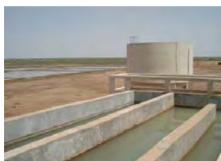
浄水場の凝集・沈殿槽
