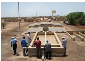
凝集・沈殿槽及び浄水層
