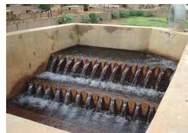
除鉄プラントの曝気槽
