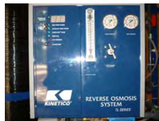
逆浸透膜パネル
