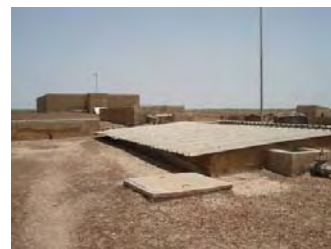
浄水層までの流入は重力式による
