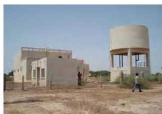
Kassac Nord の浄水場
