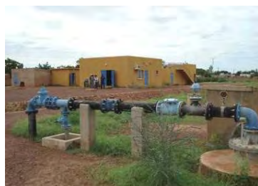
Matam 浄水場全景 (手前は深井戸)
