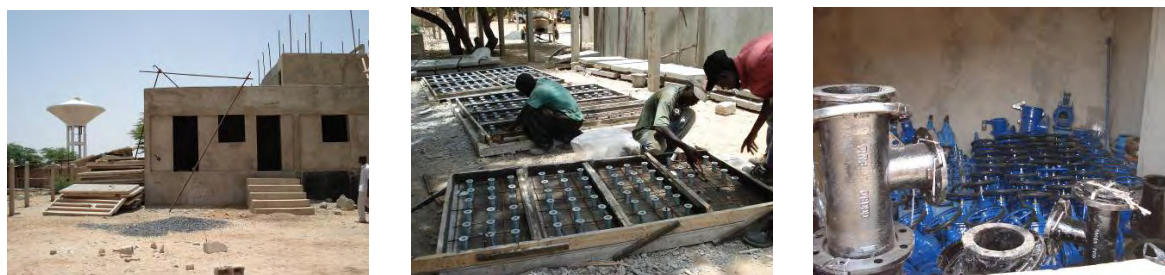
図 2-2-4 工事中の Ross Bethio 浄水場
