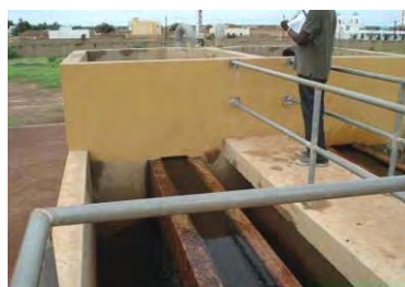
除鉄プラントの濾過槽
