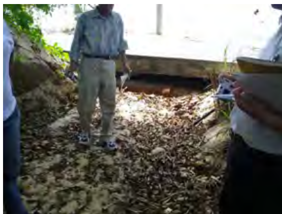
河口部の道路下のカルバートは海からの砂で閉塞
