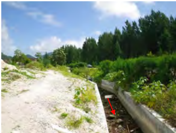
排水路の上流を見る
