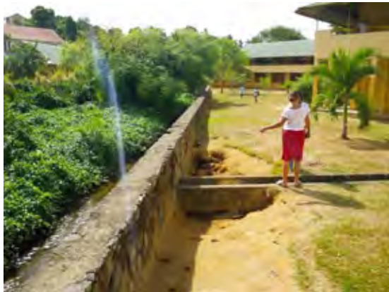
学校からの内水排除の排水路
