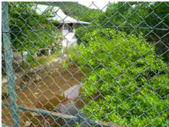
道路の橋から上流を見る
