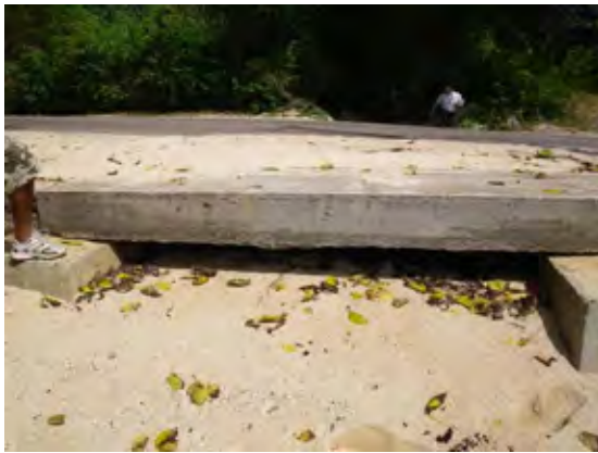
海岸側より写した河口部の閉塞
