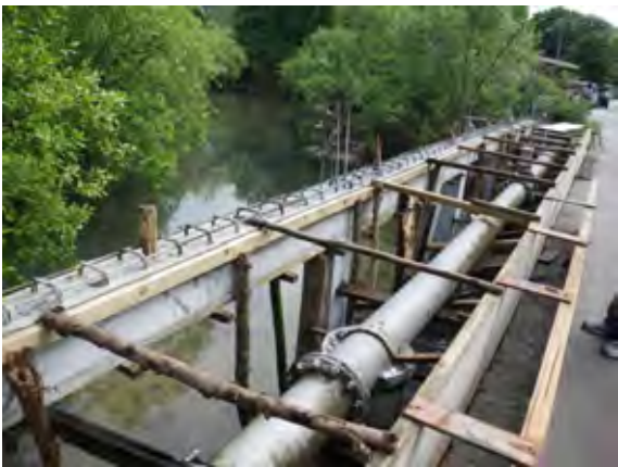
歩道や水道の橋脚も川の断面積を狭めている
