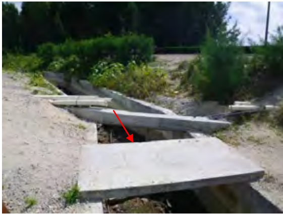
排水路の上流を見る
