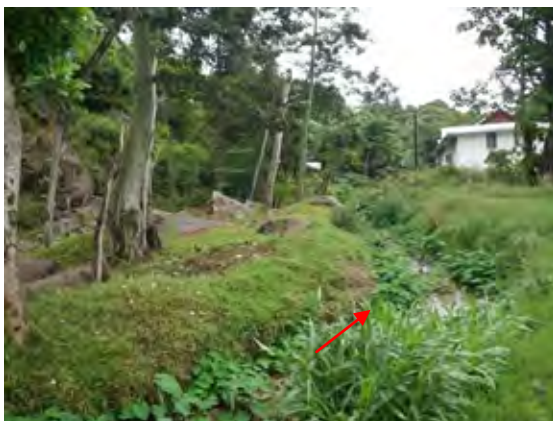
狭い流路から溢れ、周囲の住宅が浸水する
