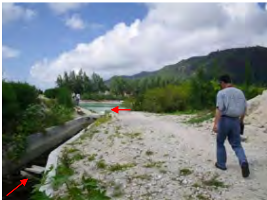
排水路の下流を見る。排水路は River Rochon に流入する。
