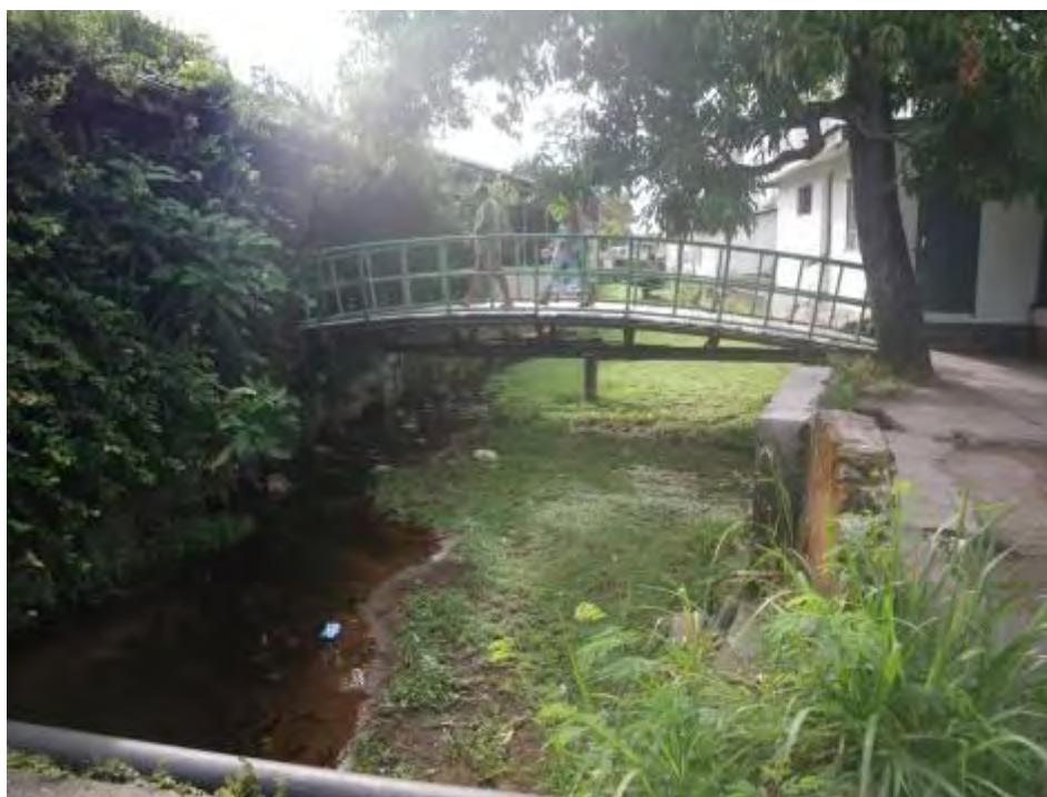
図 4-4-5 St. Louis 川 State House Gate 近くの駐車場（平常時）
