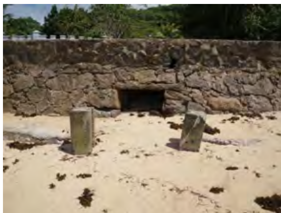
海側の出口。海水の侵入を防ぐための角落しか。
