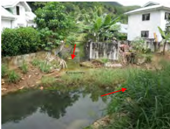
奥から排水路が合流。川の流れは、下流の水位によって、右向きだけではない可能性がある。
