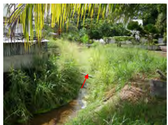
合流していた排水路の上流側（下流を見る）
