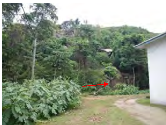
住宅の裏はすぐに山の斜面で巨礫がある
