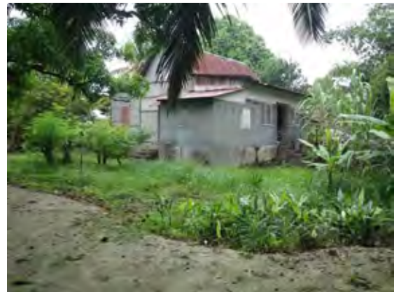
築 100 年以上との民家。家の土台を地盤より上げて作っている。昔も浸水被害はあったが、上流側で宅地開発がされてからひどくなったとのこと。
