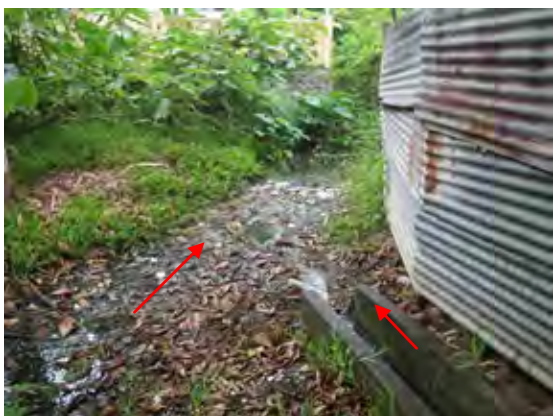
排水路とそこに流入する道路側溝
