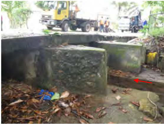
流れを良くするために橋の下の流路を片側だけ深く作り直した
