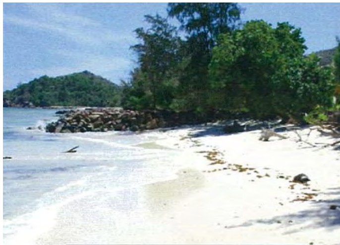
図 4-1-10 アンセ・ケランの海岸及び突堤の状況
