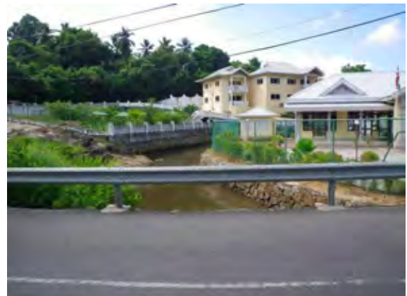
道路の橋から下流を見る。河道の線形が直角に曲がっている。
