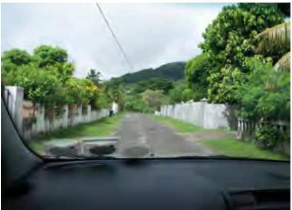
新興住宅地だが側溝等の排水網が未整備
