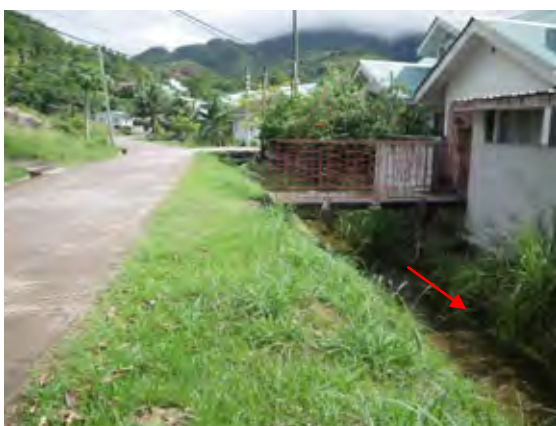
合流していた排水路の上流側（上流を見る） 民家のすぐ横を流れる
