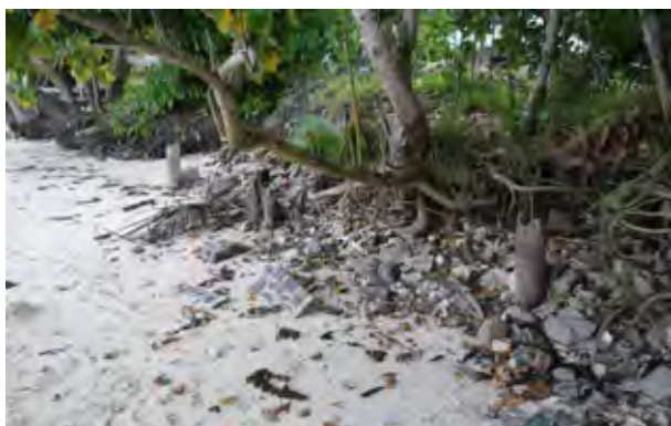
写真1 海岸侵食状況 (ベ・ラザール)
