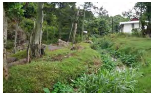
写真8 排水路 (アンセ・オ・ピン)
