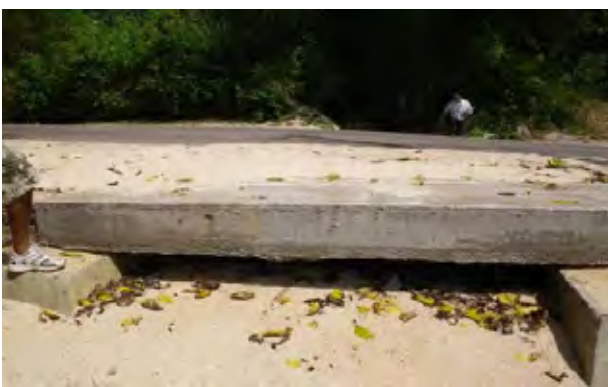
写真4 河口部閉塞 (アンセ・オ・ピン)
