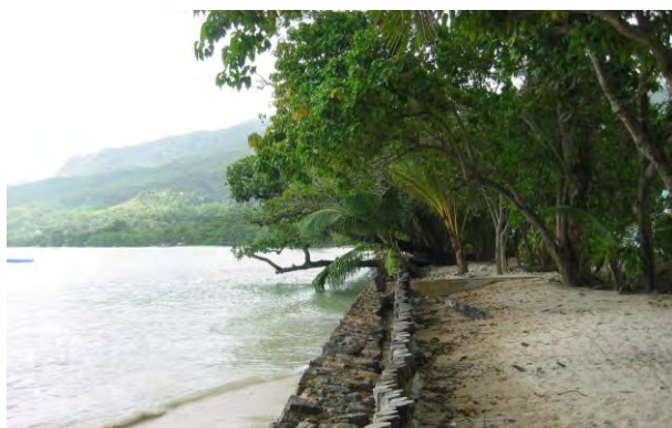
写真3 護岸対策 (アンセ・ボアール)
