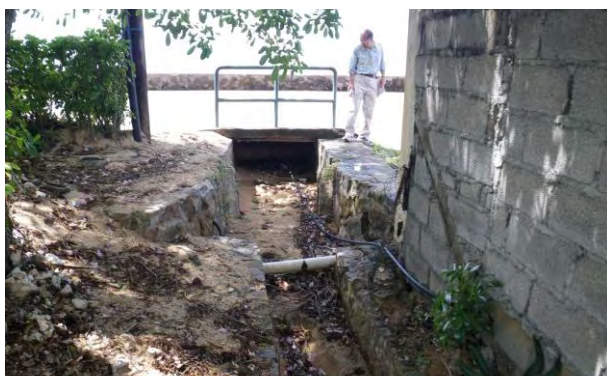
写真7 砂で閉塞したカルバート (オ・カップ)
