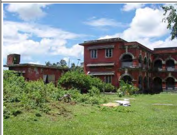
SK病院（奥カラ・アザール病棟） 手前空き地はカラ・アザール研究センター構想 建設予定地（2010年8月）
