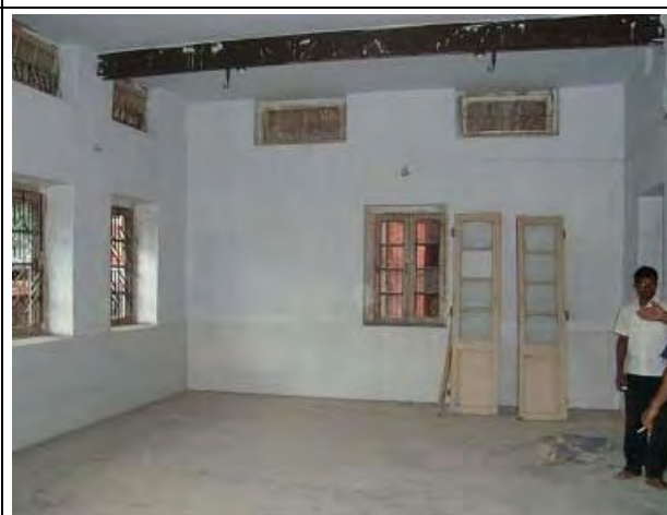
SK病院 工事中病棟（2010年10月）
