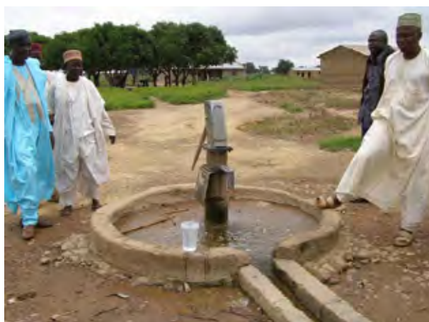
「ナ」国側が建設したワサグ村の深井戸状況。集落の中心に井戸が位置している。井戸周辺には住居・畑はなく、広場となっている。村落住民組織が井戸の維持管理を行っている。
