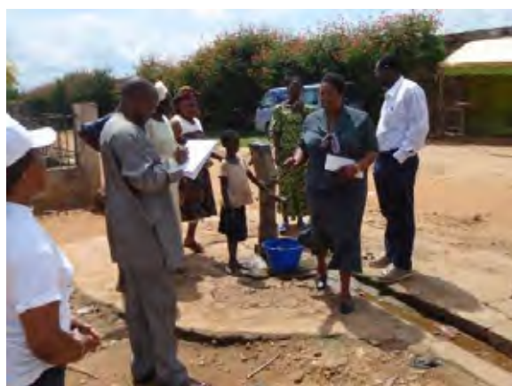
「ナ」国側が建設した Hara Moken 村の深井戸給水施設の様相。1993 年 UNICEF の支援によって掘削された。人口 5,000 人に対しこのハンドポンプ井戸 1 本のみあり、1 人当たりの給水量は 1.40/日程度である。給水量は国家目標値の 20 分の 1 に過ぎない。WASHCOM が設立され維持管理を実施している。井戸の深さは深度 50m 程度、地下水位 20m 程度であり、標準的な井戸である。
