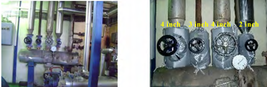
図 6-6 保温ジャケット取付状況（左：取付前、右：取付後）
