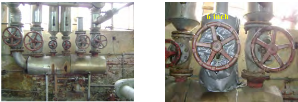
図 6-8 保温ジャケット取付状況（左：取付前、右：取付後）
