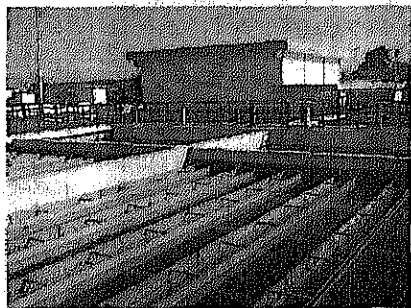
Planta potabilizadora después de la remodelación.
