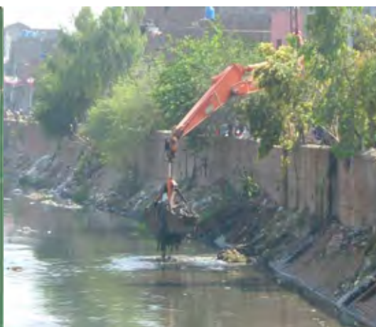
排水路の清掃風景
