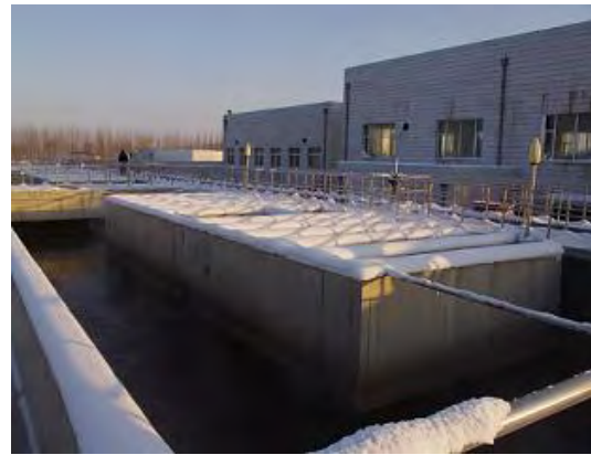
図 3 長春汚水処理場
