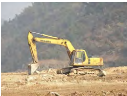
図 8 4-2)長沙市ゴミ衛生埋め立て処分場建設：資機材（掘削機）
