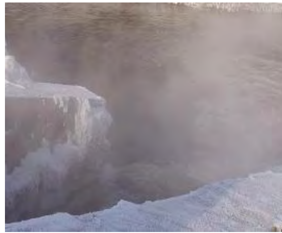
図 7 污水处理場の放出口
