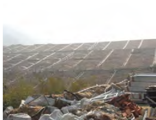
図 9 4-2)長沙市ゴミ衛生埋め立て処分場建設：ゴミ埋め立て処分場側溝
