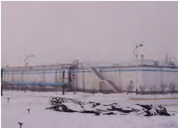
図 2 松原汚水処理場
