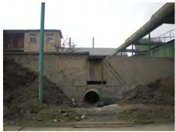
図 3 開封市化学肥料工場廃水処理対策事業の設備撤去跡
