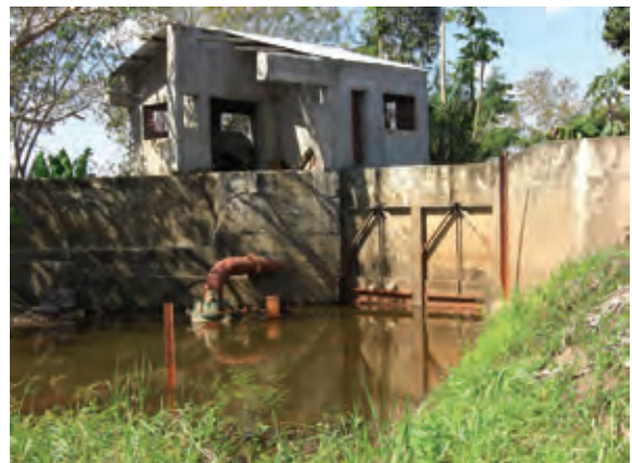
貯水位が高いときに開閉する取水ゲートとポンプ場（Munda-munda 地区）
