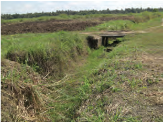
Intabo 地区の幹線水路。土水路であり、分水地点にも水利構造物がない。水路を渡る簡単な橋はある。
