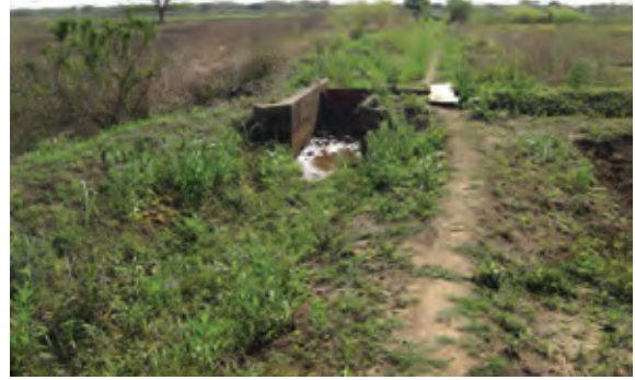
ポンプ場からの水路はライニングされていない。分水工が見える。(同左)
