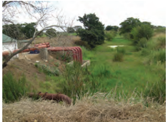
フランスの援助で完成した排水機場。
