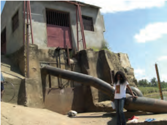
Intabo 地区（600ha）の洪水取水要ゲートとポンプ（エンジンは上の小屋の中にあり、運転時はベルトでつながれる）
