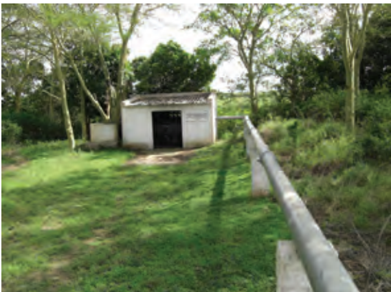
SSIP (AfDB) で建設されたポンプ場。完成の 6 カ月後にその運転は休止された。 (Salamanga 近郊)
