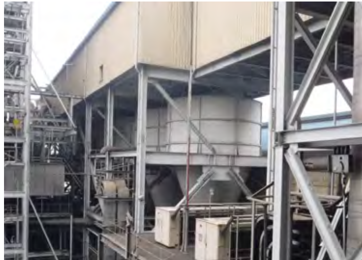
Hình 2.3-12 Boong ke than ở nhà máy Phả Lại II
