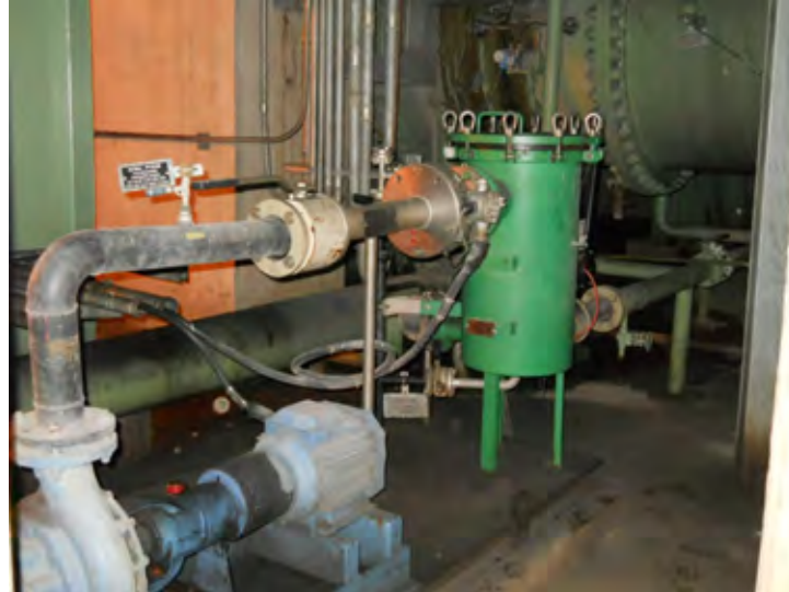
Hình 2.5-7 Thiết bị vệ sinh sử dụng bi
