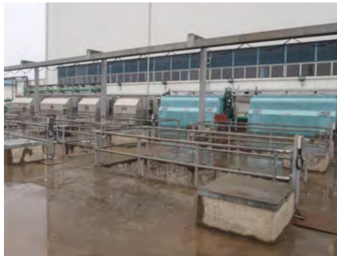
Hình 3.3-32 Lưới chắn dạng quay (bên trái ảnh có 2 lưới chắn dùng cho tổ máy số 7, ở giữa là 2 lưới dùng cho tổ máy số 5,6, 2 lưới chắn bên phải màu xanh dùng cho tổ máy số 8 đang được xây dựng )
