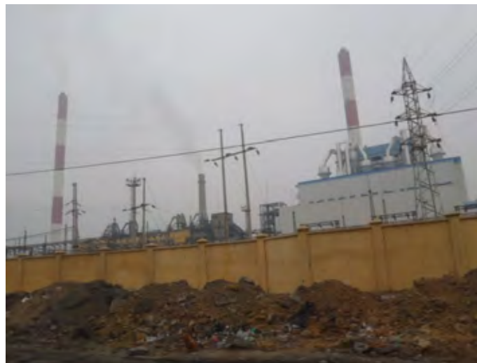
Hình 3.4-1 Ống khói tổ máy Uông Bí số 7 (bên trái ảnh), ống khói tổ máy Uông Bí số 5, 6 (ở giữa) và ống khói đang được xây dựng của tổ máy Uông Bí số 7 (bên phải )
