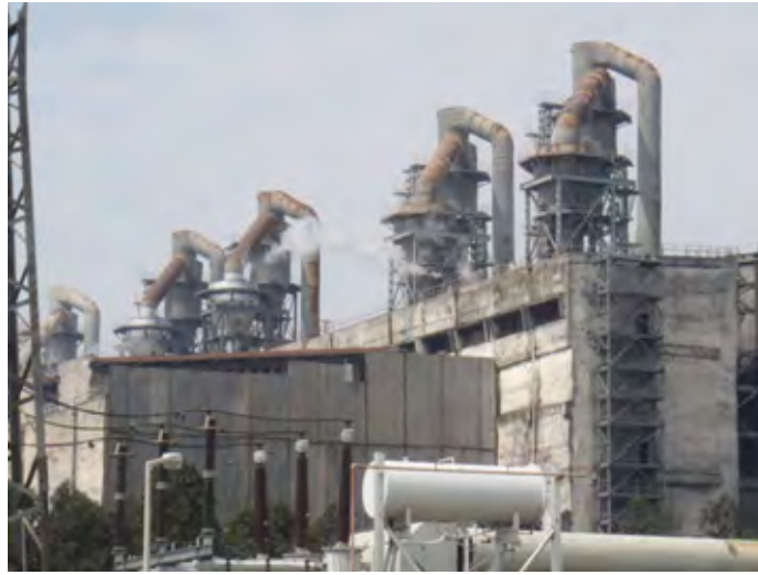
Hình 2.3-17 Máy tách cyclone Phả Lại I
