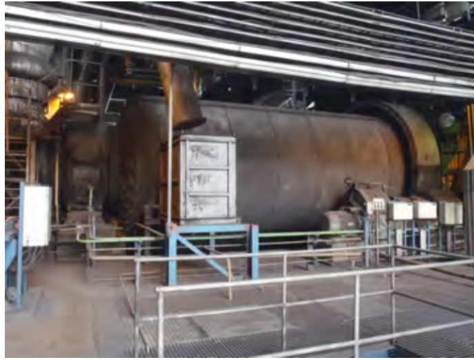
Hình 3.3-17 Máy nghiền dạng ống tổ máy Uông Bí số 7
