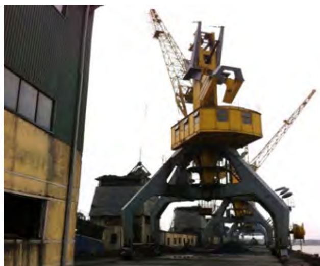
Hình 2.3-4 Cầu trục dỡ than dây cân bằng của nhà máy Phả Lại I
