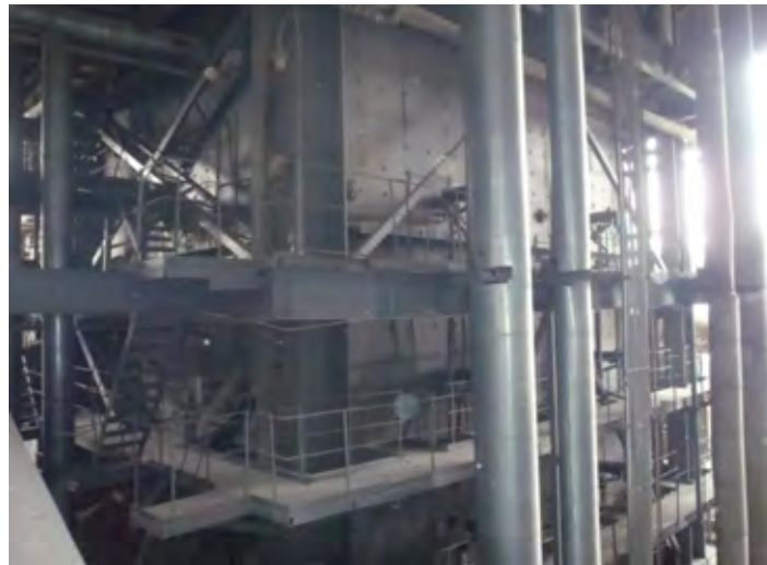
Hình 2.3-24 Bộ sấy không khí nhà máy Phả Lại I (dạng ống, không thể xác định được bằng quan sát bên ngoài)
