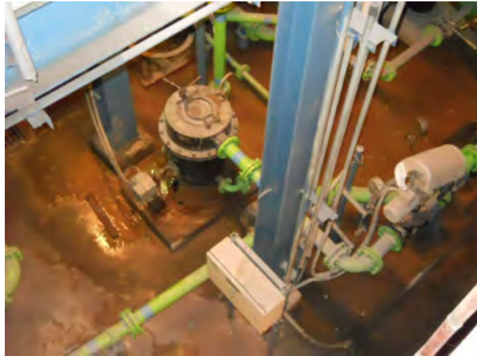
Hình 3.3-43 Thiết bị làm sạch bình ngưng ở tổ máy Uông Bí số 7
