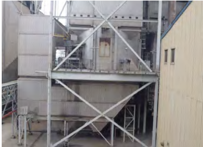
Hình 2.3-25 Bộ sấy không khí nhà máy Phả Lại II
