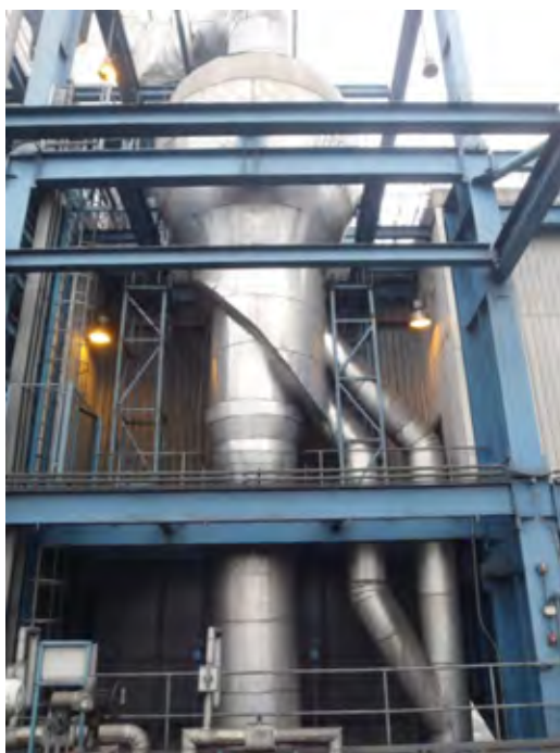
Hình 3.3-19 Máy tách than của tổ máy Uông Bí số 7
