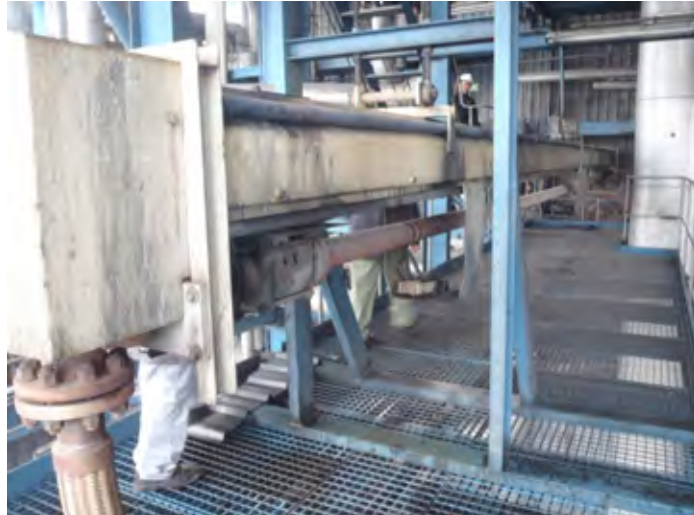
Hình 3.3-29 Quạt thổi muối than kiểu xoay ở tổ máy Uông Bí số 7
