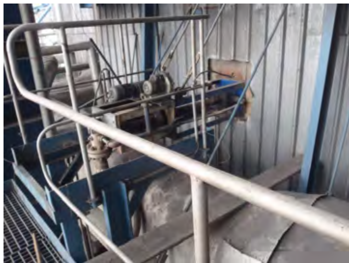
Hình 3.3-30 Cơ cấu cố định ở tổ máy Uông Bí số 7
