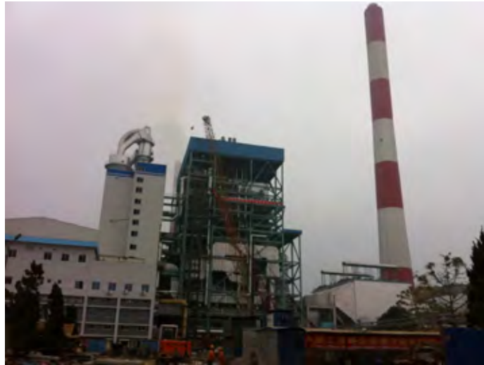
Hình 3-3 Tổ máy Uông Bí số 8 đang xây dựng ( dự kiến sẽ đi vào hoạt động năm 2012 300MW )
