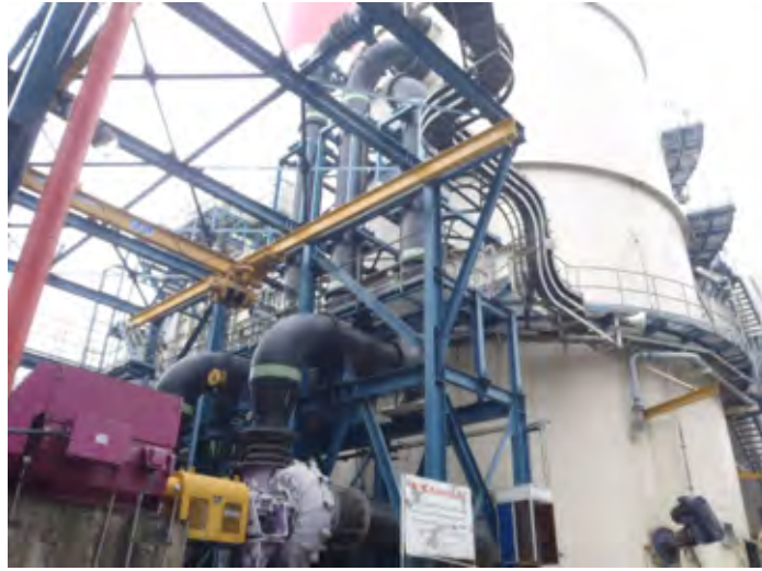
Hình 3.4-4 Thiết bị khử lưu huỳnh ở tổ máy Ung Bí số 7
