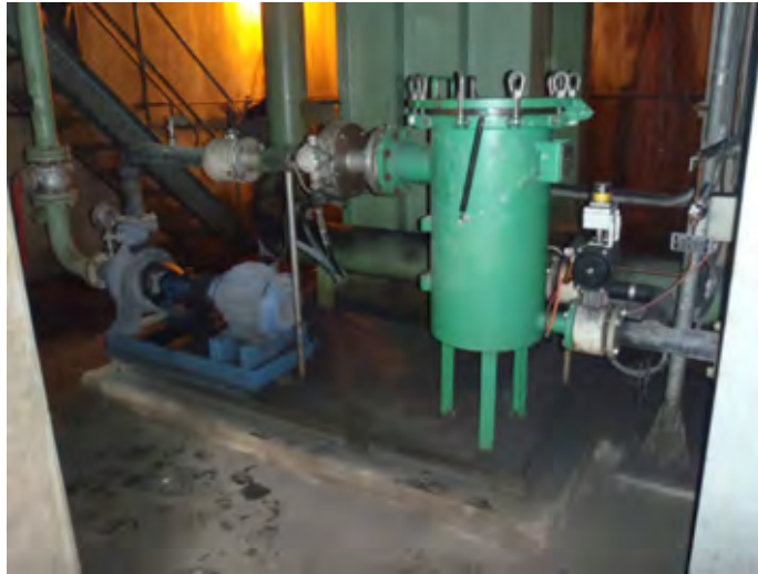
Hình 2.3-41 Thiết bị làm sạch bình ngưng
