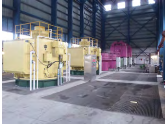
Hình 3.3-33 Toàn cảnh lò hơi (ảnh bên trái, CWP màu vàng dùng cho tổ máy số 8 đang xây dựng)
