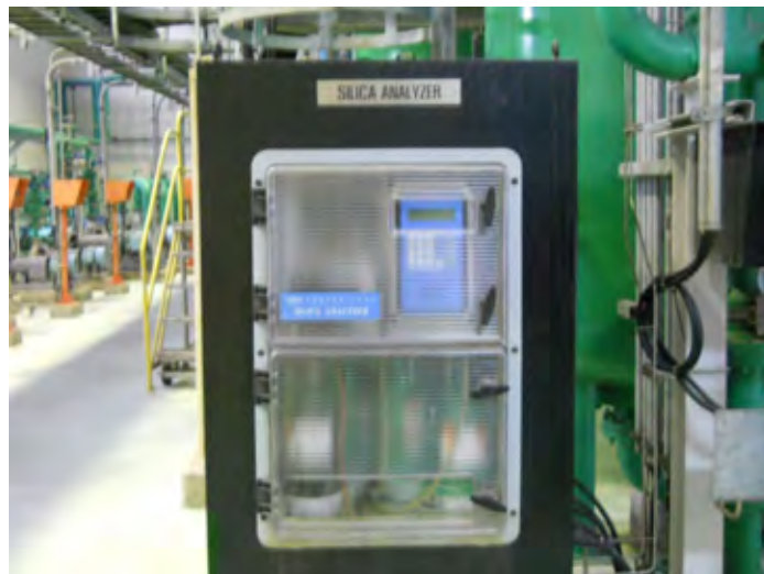
Hình 2.5-8 Thiết bị phân tích silica đang hỏng
