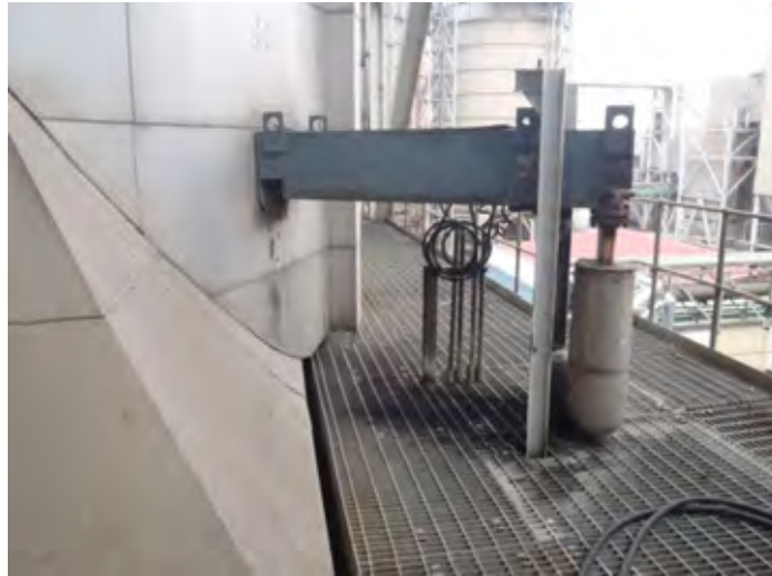
Hình 2.3-27 Quạt thổi muội than dùng cho bộ sấy không khí của nhà máy Phả Lại II
