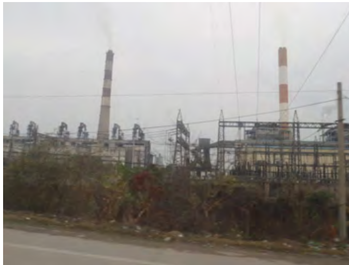
Hình 2.4-1 Ống khói nhà máy Phả Lại I (bên trái), Ống khói nhà máy Phả Lại II (bên phải)
