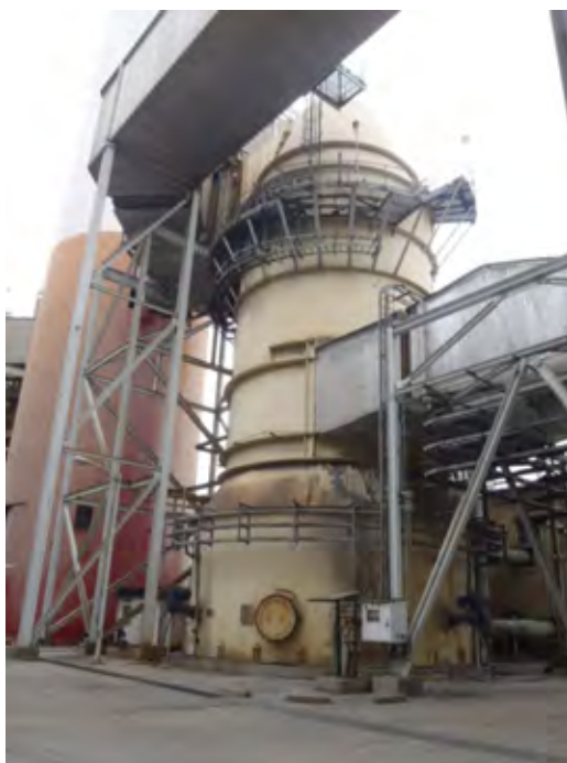
Hình 2.4-4 Thiết bị khử lưu huỳnh trong khí thải kiểu ướt
