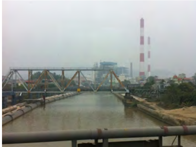
Hình 3.3-31 Đường ống nước tới nhà máy phát điện (phía trái ảnh, chạy dọc bờ sông có các đường ống nước)
