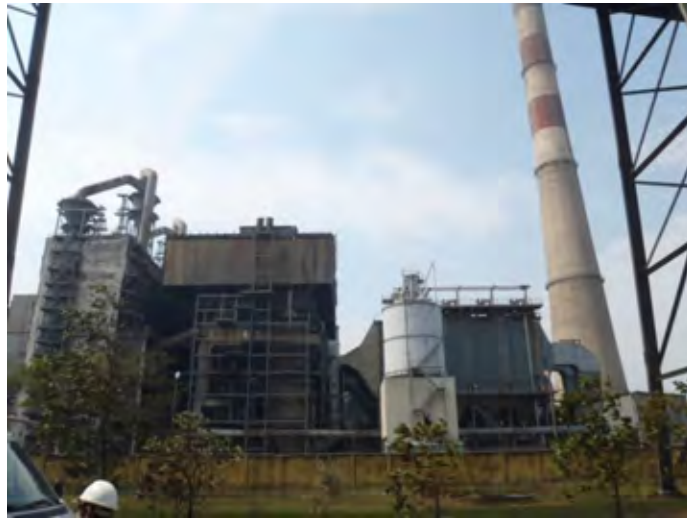
Hình 2.2-1 Hình ảnh lò hơi nhà máy Phả Lại I
