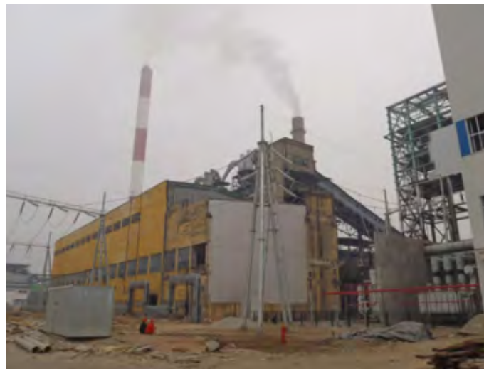
Hình 3-1 Hình ảnh tổ máy Uông Bí số 5, 6
