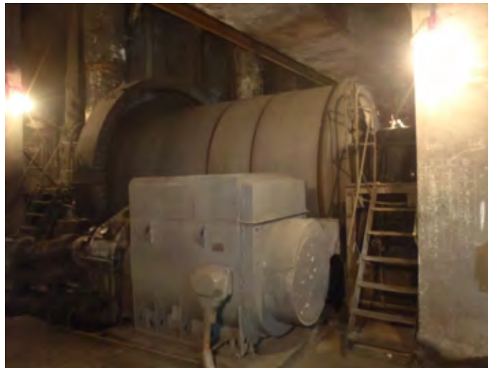
Hình 3.3-16 Máy nghiền dạng ống tổ máy Uông Bí số 5, 6
