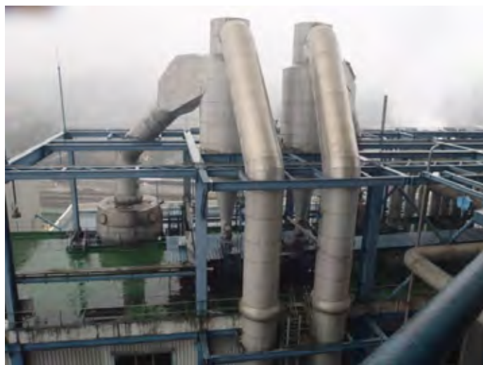
Hình 3.3-20 Máy phân ly cyclone của tổ máy Uông Bí số 7
