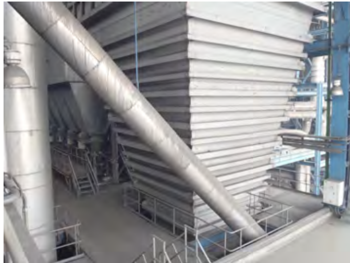
Hình 3.3-12 Boong ke than của tổ máy Uông Bí số 7
