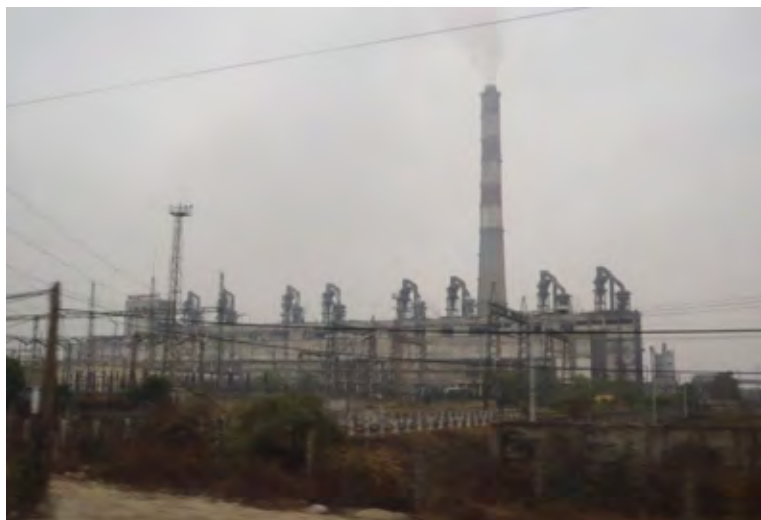
Hình 2-2 Hình ảnh nhà máy Phả Lại I
