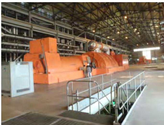
Hình 2.2-7 Hình ảnh tuabin, máy phát điện nhà máy Phả Lại II
