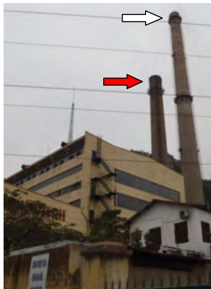
Hình 1.4-1 Ống khói đã được nâng chiều cao (mũi tên trắng chỉ ống khói sau khi sửa lại (130m), mũi tên đỏ chỉ ống khói lúc trước khi sửa (80m))
