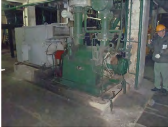
Hình 1.3-20 Bơm cấp nước cho lò hơi
