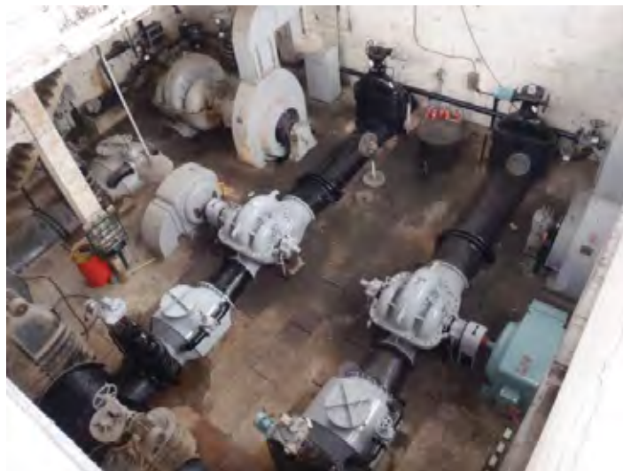
Hình 1.3-19 Bơm tuần hoàn
