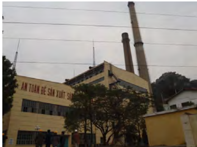
Hình 1-2 Nhà máy nhiệt điện Ninh Bình
