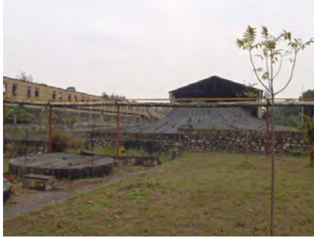
Hình 1.3-5 Toàn cảnh bãi chứa than có mái che
