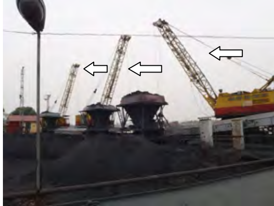
Hình 1.3-3 Toàn cảnh thiết bị vận chuyển than lên (Mũi tên chỉ thiết bị cầu tạt hành, kiểu gầu xúc dùng tời kéo)
