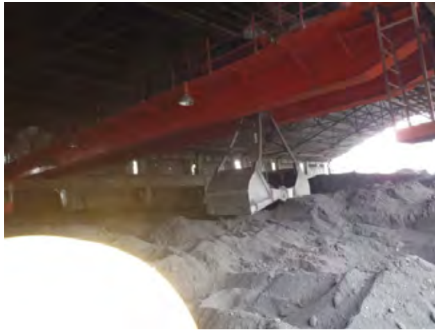
Hình 1.3-6 Cận cảnh bãi chứa than trong nhà
